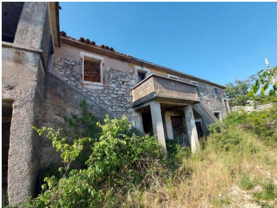
Sl. 1.3.1.2.2.2-6 Napušteni nadzemni objekt u selu Plenčiči
