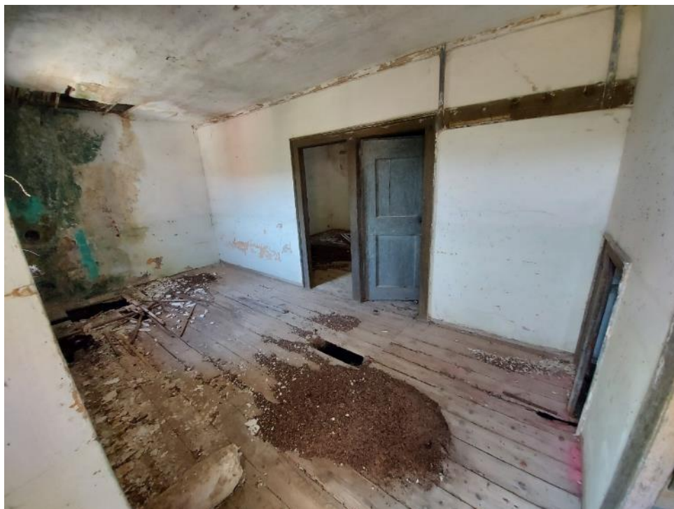
Sl. 1.3.1.2.2.2-7 Napušteni nadzemni objekt, prikaz unutrašnjeg prostora s tragovima guana, u selu Plenčiči
