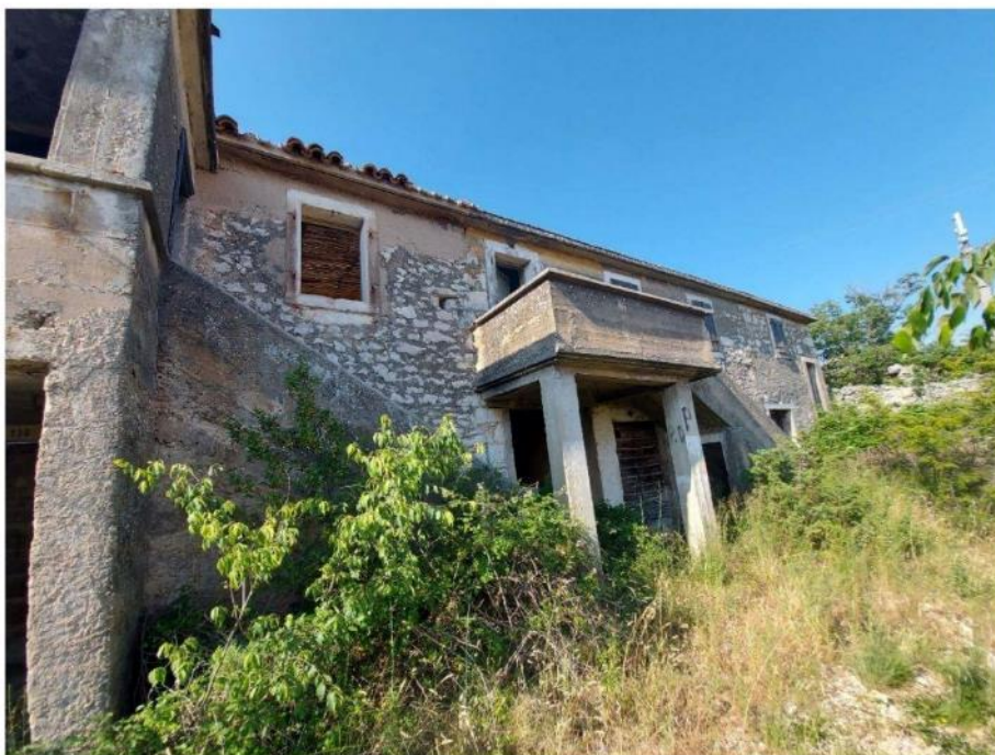
Slika 17 - Napušteni nadzemni objekt u selu Plenčiči
